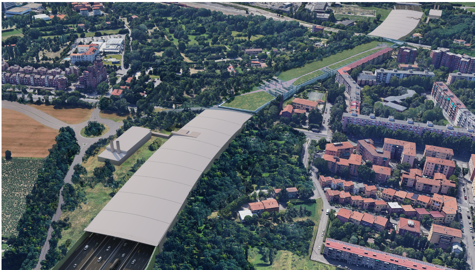
Figura 1-12 Galleria San Donnino - vista aerea - centrale di filtrazione esterna
