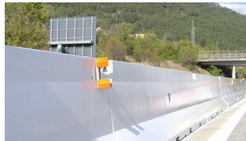
Figura 2-2 Applicazione su barriera di sicurezza tipo New Jersey
