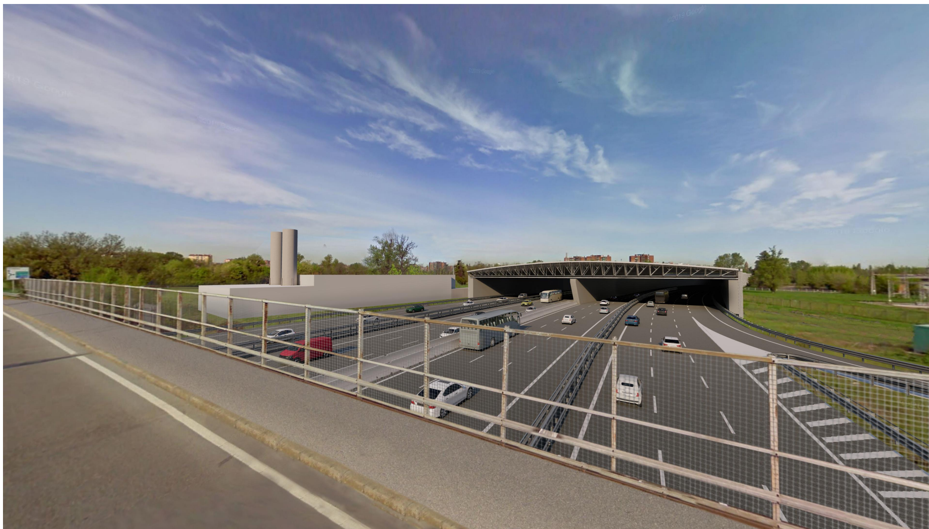
Figura 1-15 Galleria San Donnino - vista da terra - centrale di filtrazione esterna
