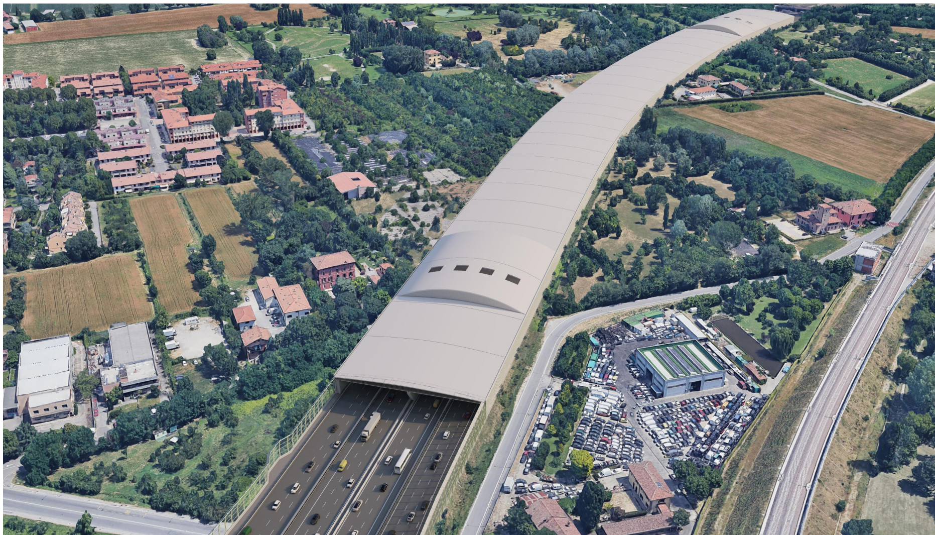
Figura 1-8 Galleria Zanardi - vista aerea - centrale di filtrazione in copertura
