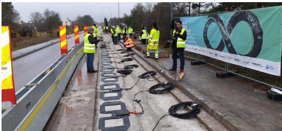
Figura 3-1 Installazione di una porzione del sistema di ricarica wireless sviluppato da Electron sulla Smart Road di Gotland.
