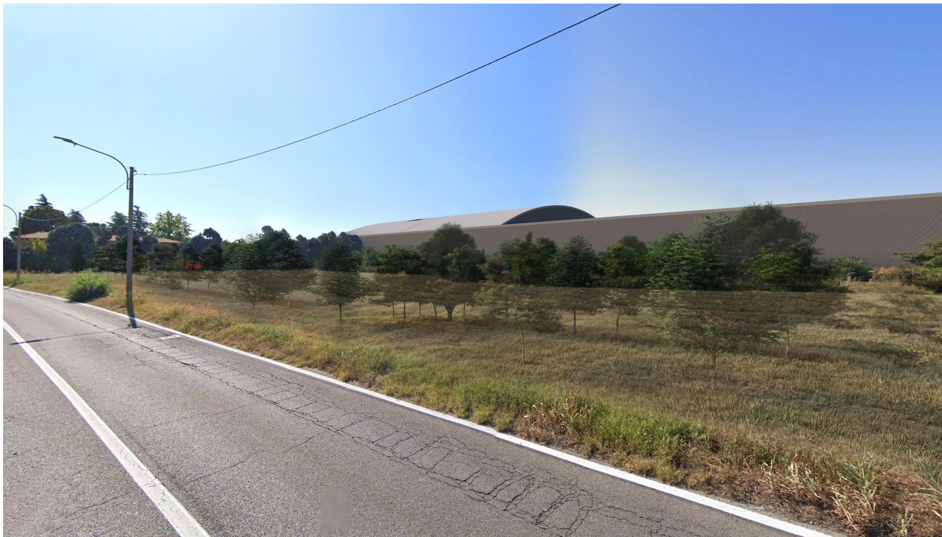
Figura 1-24 Galleria Croce del Bianco - vista da terra - centrale di filtrazione in copertura
