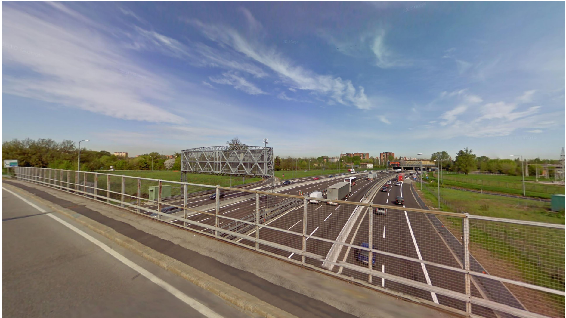
Figura 1-14 Galleria San Donnino - vista da terra - stato di fatto
