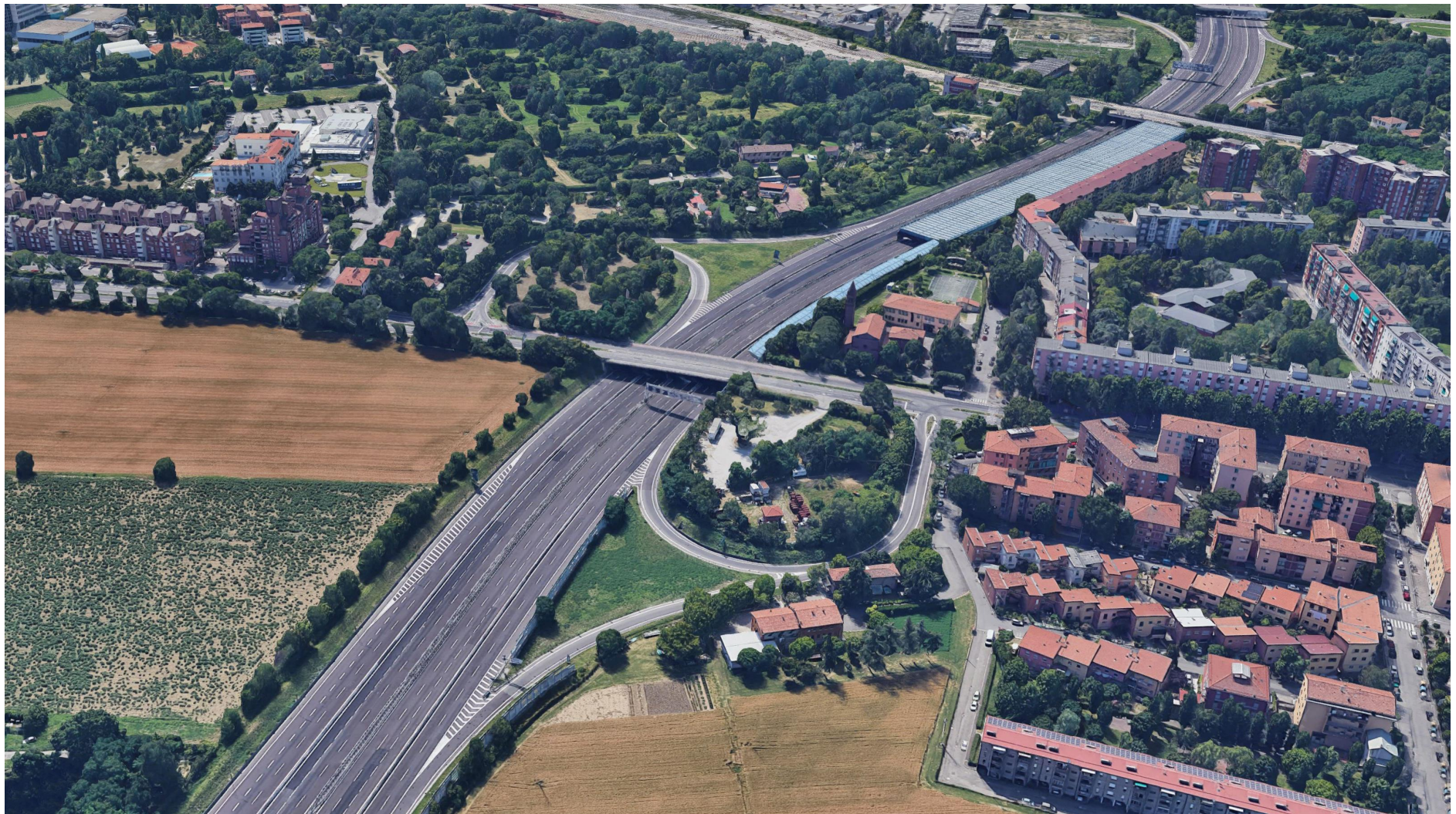
Figura 1-11 Galleria San Donnino - vista aerea - stato di fatto
