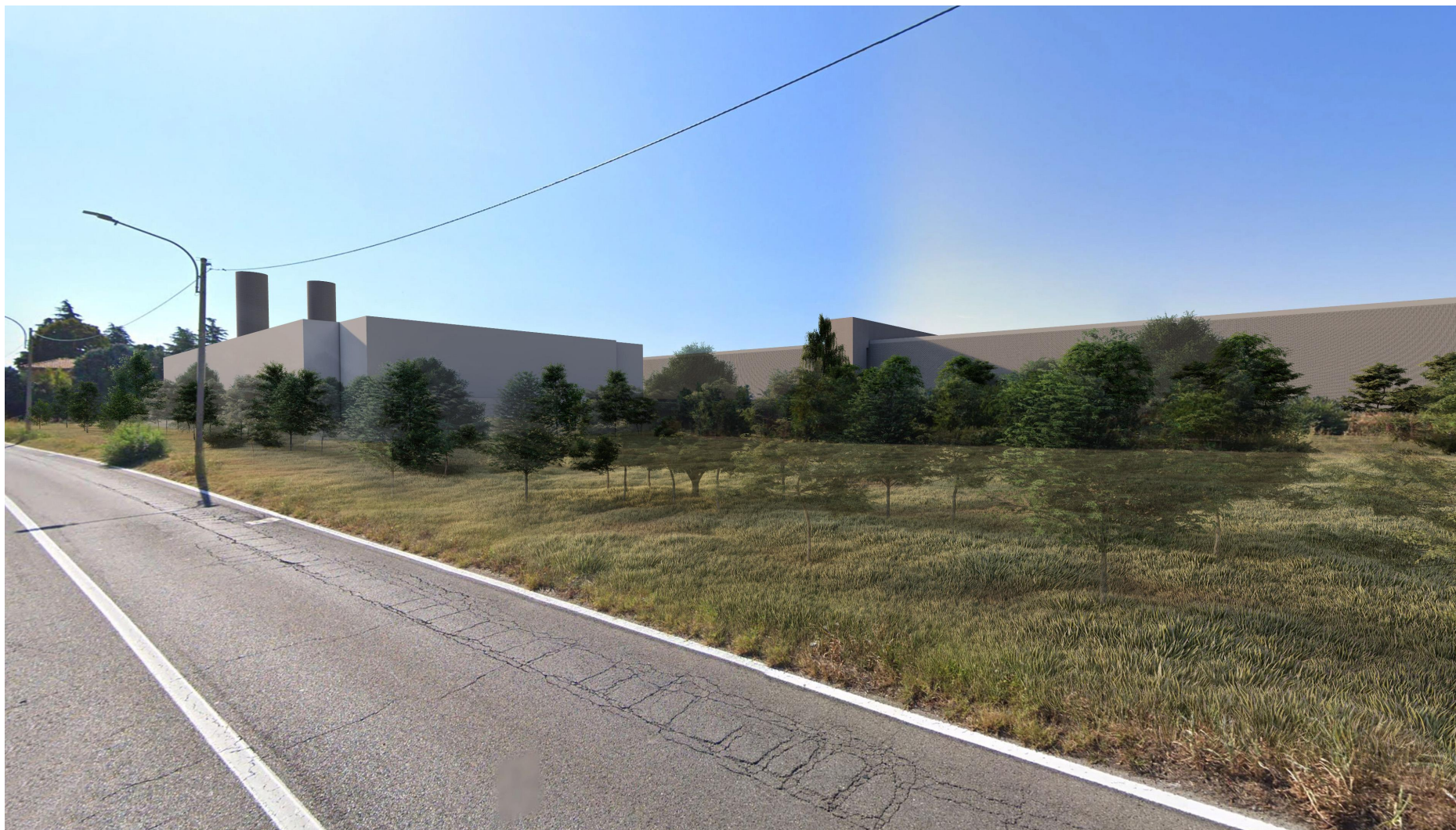
Figura 1-23 Galleria Croce del Bianco - vista da terra - centrale di filtrazione esterna
