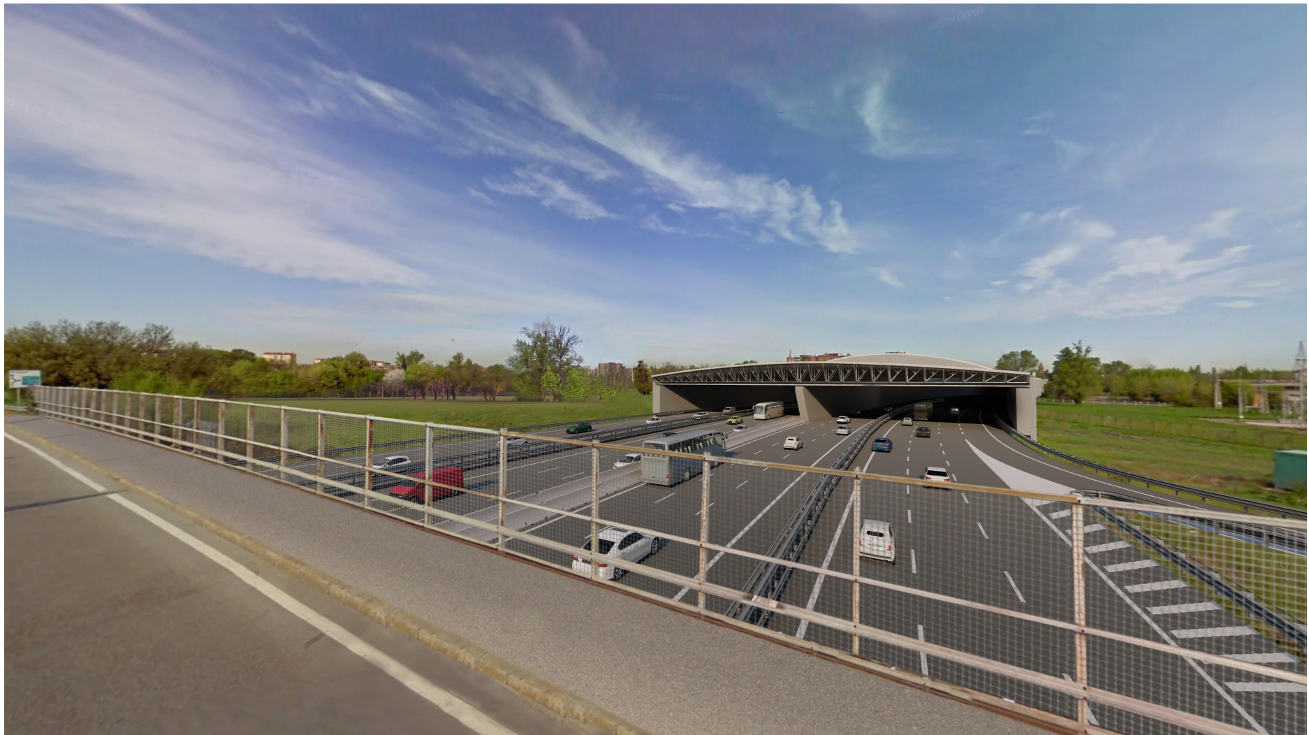
Figura 1-16 Galleria San Donnino - vista da terra - centrale di filtrazione in copertura
