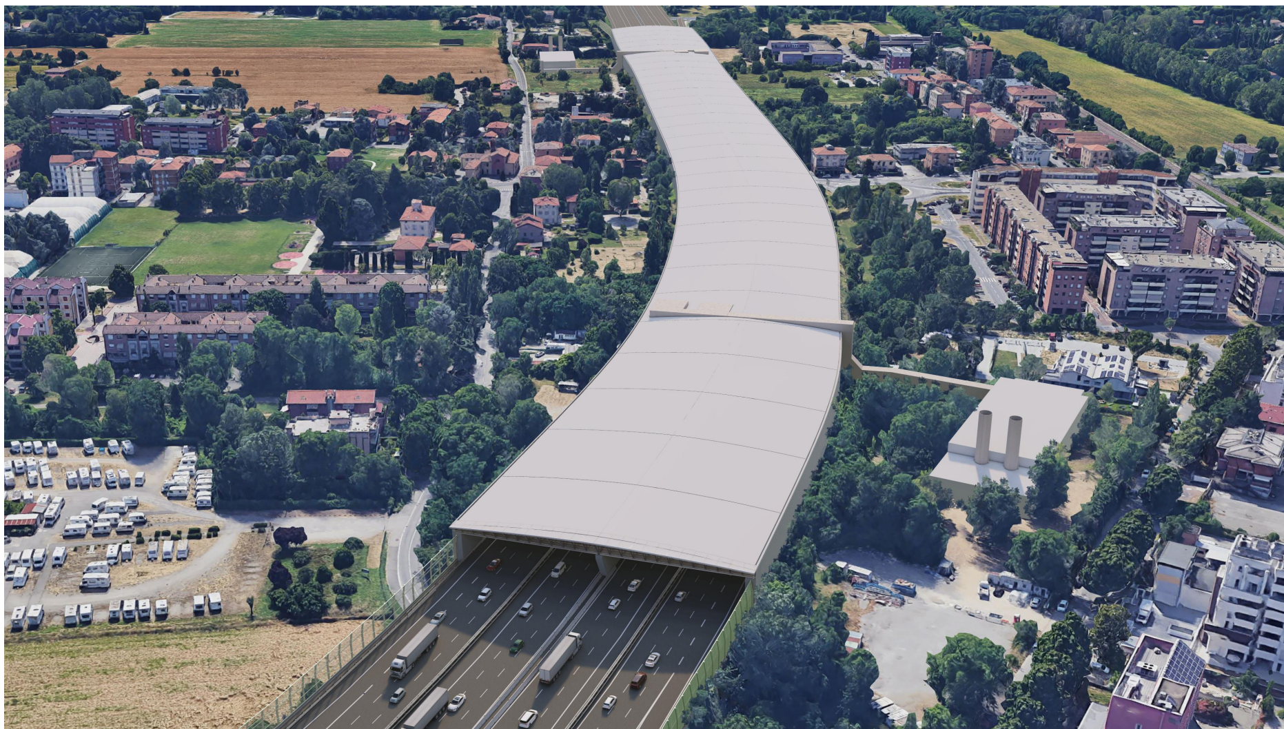
Figura 1-20 Galleria Croce del Bianco - vista aerea - centrale di filtrazione esterna
