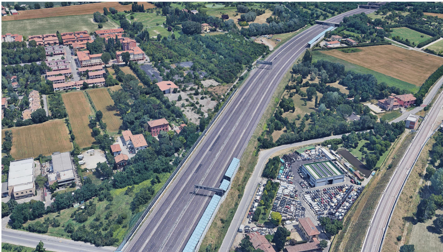
Figura 1-6 Galleria Zanardi - vista aerea - stato di fatto
