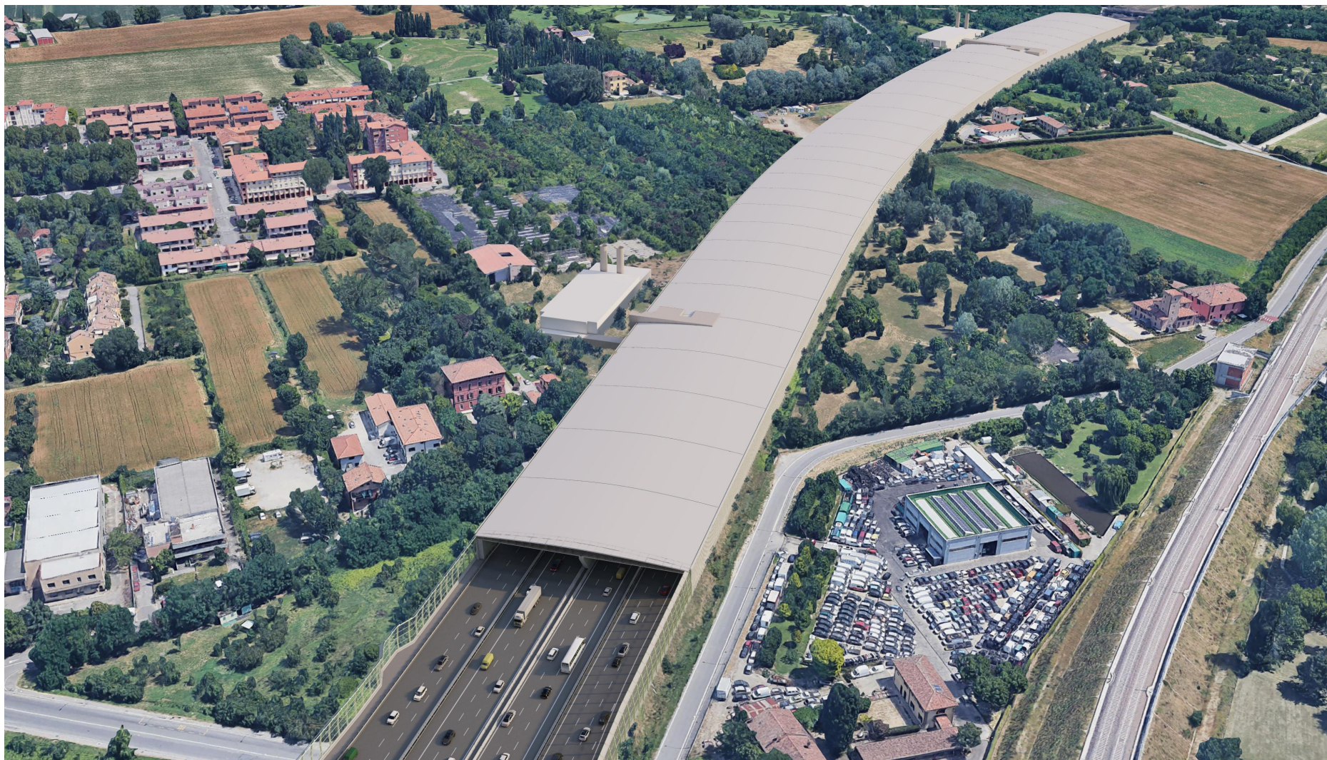
Figura 1-7 Galleria Zanardi - vista aerea - centrale di filtrazione esterna
