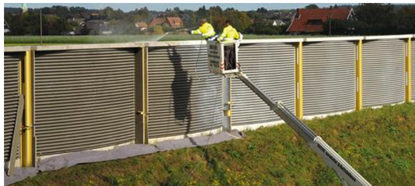
Figura 2-1 Applicazione di vernice fotocatalitica su barriera fonoassorbente
