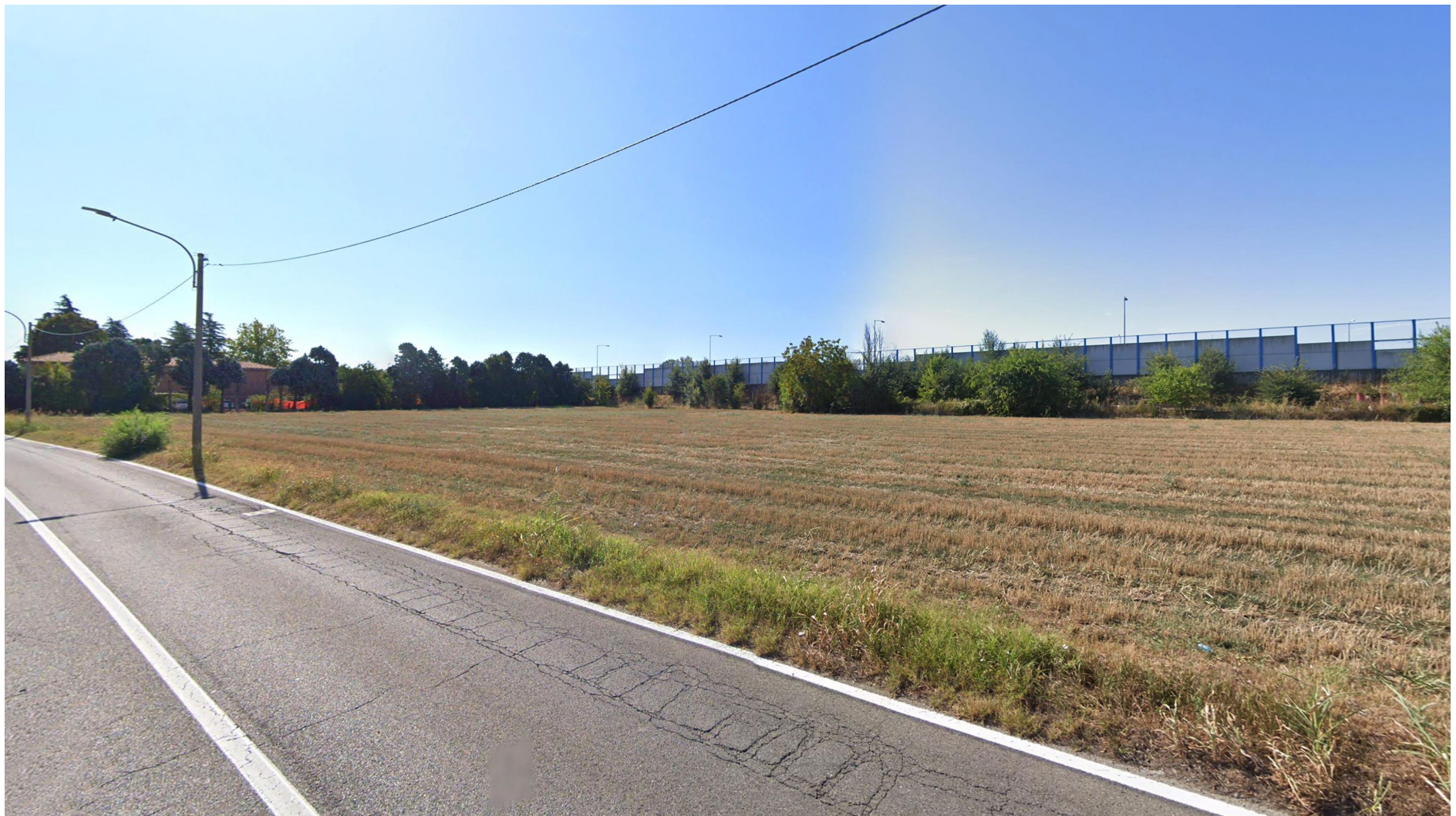
Figura 1-22 Galleria Croce del Biacco - vista da terra - stato di fatto
