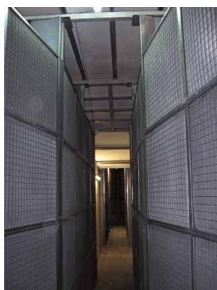
Figura 31. Caratteristiche pannelli ai carboni attivi per processo denitrificazione
